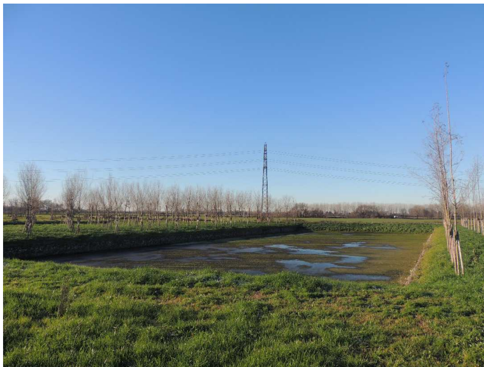
Fig.1 – Scorcio delle vasche in asciutta dell'impianto di fitodepurazione.
