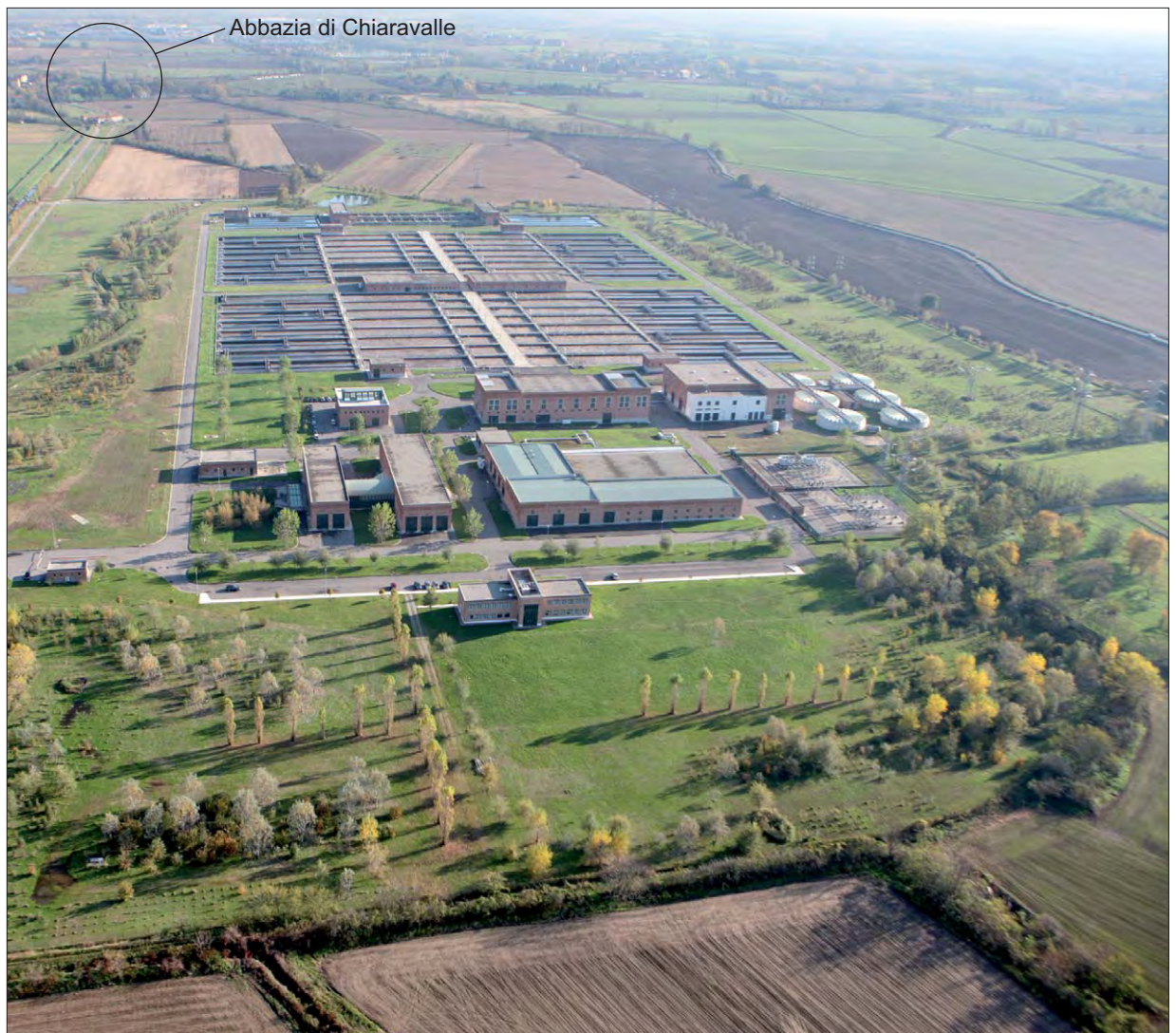
Fig. 5 – Le aree una volta destinate a marcite sono state oggi utilizzate per la realizzazione dell’impianto di depurazione di Nosedo, uno dei tre impianti che oggi servono la città di Milano. Sullo sfondo, in lontananza, si scorge il campanile dell’Abbazia di Chiaravalle
